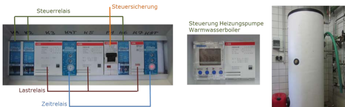
Abb. 4: Steuerung der Eiswasser- und Warmwasserproduktion
